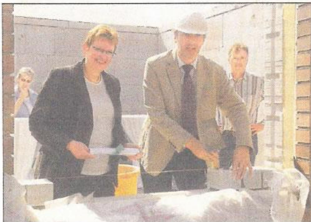
Angelika Adebahr und Bürgermeister Hans-Jürgen Detje bei der „Grundsteinlegung“ im halbfertigen Rohbau: Bereits in dieser Woche sollen die Decken geschüttet werden Foto:hr
